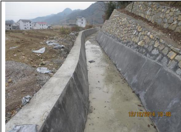
施工期灌区配套工程区干渠边坡防护
